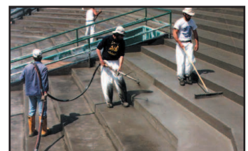
Restauración de Concreto
