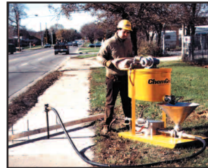
Reflagación de losas
