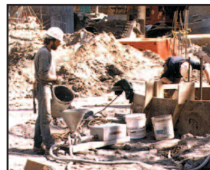
Encofrado de pilotes
