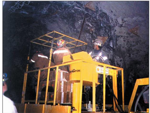
El Modelo 542H, que se muestra arriba inyectando pernos de roca, es ideal para lechadas de cemento no fluidas con relaciones agua/cemento tan bajas como 0.40 (0.35 con Super "P").
